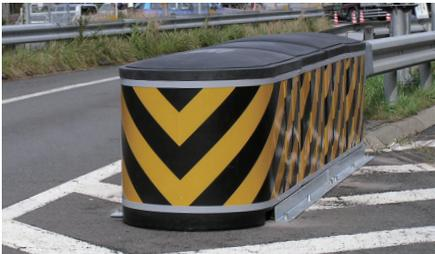
Gガードは高速道路などの分岐・分流部に設置された衝撃吸収材です。NEXCO東日本、中日本、西日本とシーエンジが共同開発した製品です。
